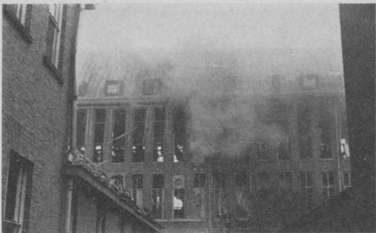
Post- en Telegraafkantoor Keizerstraat, door de Duitschers met springladingen vernield, op het moment van uitslaanden brand
