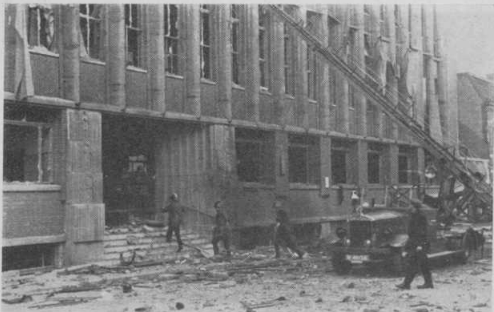
Pogingen van de Bredasche brandweer om den brand in het vernielde Post- en Telegraafkantoor te blusschen
